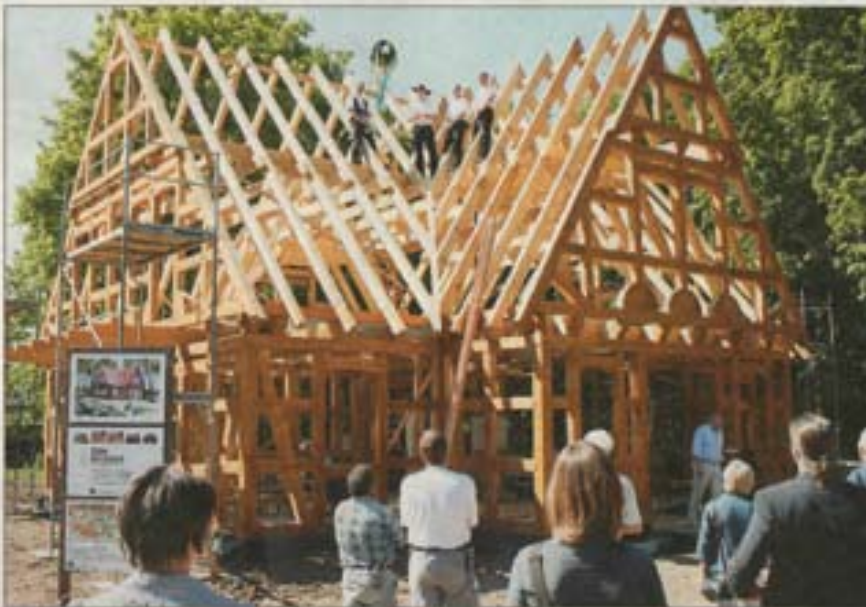
In luftiger Höhe: Die Zimmerleute Marko Haase (von links), Kai Murken, Volker Jacobs und Heino Poppe übergeben den Rohbau beim Richtfest.
